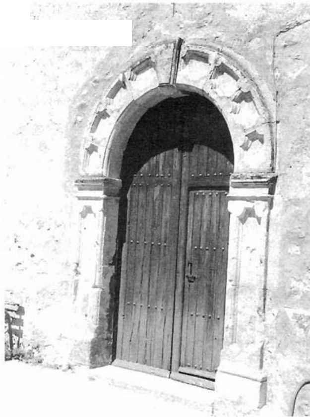
Portada meridional de la iglesia de Santibáñez del Val (Burgos).
